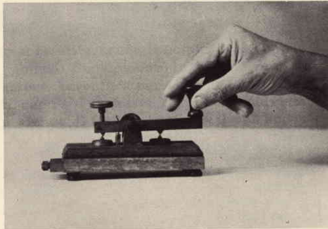
Fig. 4 - Tasto manipolatore di tipo telegrafico usato anche in radiotelegrafia nel periodo anteguerra.
