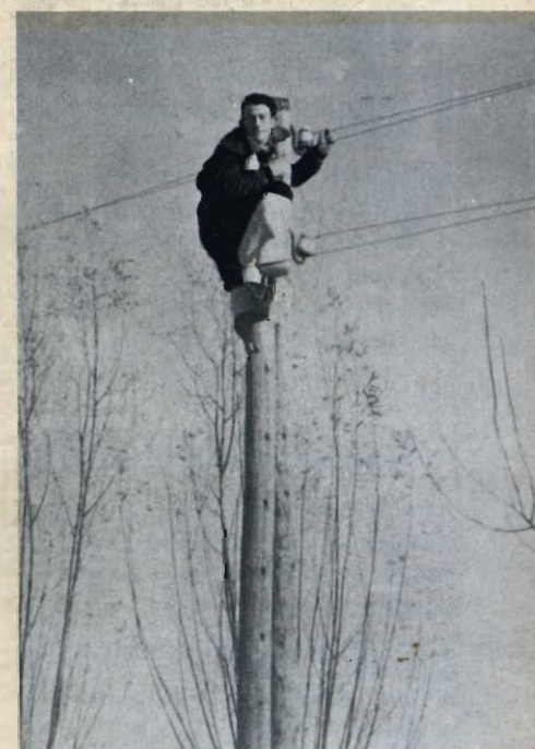
Fig. 7 - I radioamatori oltre a svolgere un'utilissima azione di radiocollegamento, ripristinavano spesso le normali linee di collegamento telefoniche e telegrafiche. Ecco un OM al lavoro su di una palificazione.
