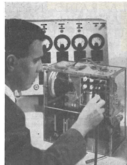
Ecco il televisore costruito interamente con transistori di congiunzione dal centro di ricerche Davide Sarnoff della RCA, che ha formato l'oggetto di un articolo sul numero scorso. In questo numero alcune interessanti descrizioni a pag. 14 di apparecchiature impieganti i nuovi transistori di congiunzione. (Radio Electronics)
