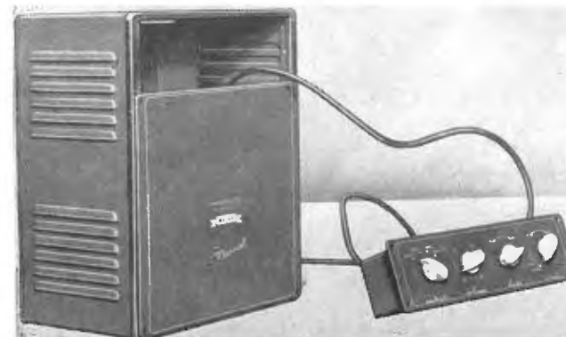
L'amplificatore « Musical » in cassetta metallica. Il preamplificatore può essere installato anche a distanza ed in posizioni diverse.
