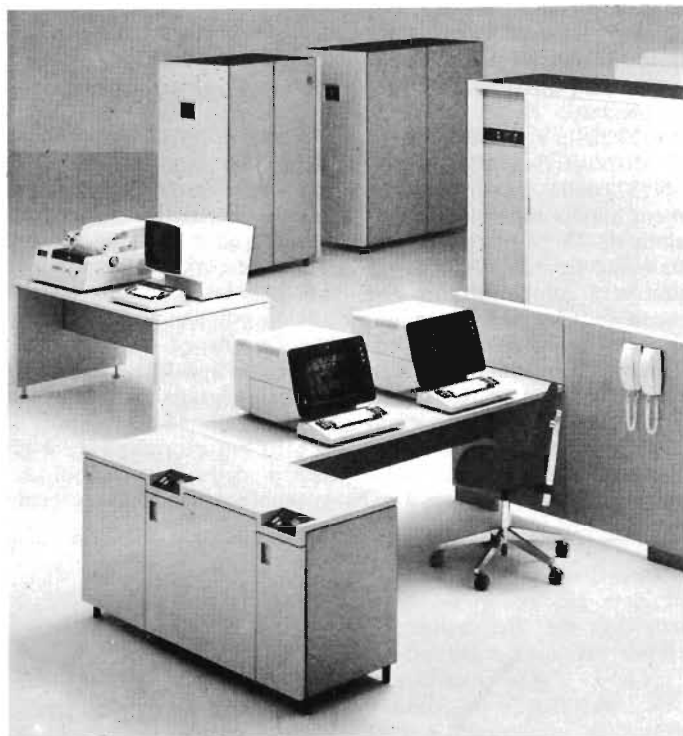
Nella foto, vista di un razionale complesso di elaborazione della IBM Italia, in una sofisticata architettura. Oltre alle unità di raffreddamento, alimentazione, controllo ed elaborazione si notino il banco del terminale video con stampante e il banco per l'operatore con terminale video a colori.
