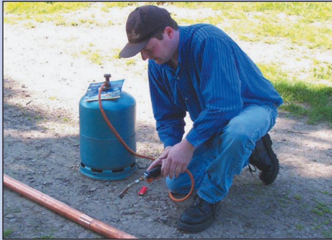
5 : François, F5SDH, soude le tube de 10 m constituant la verticale 7 MHz.
