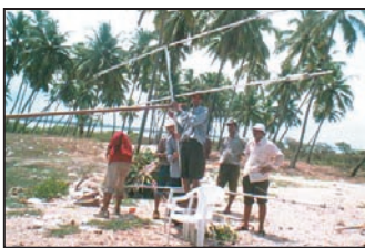
Assemblage d'une antenne.
