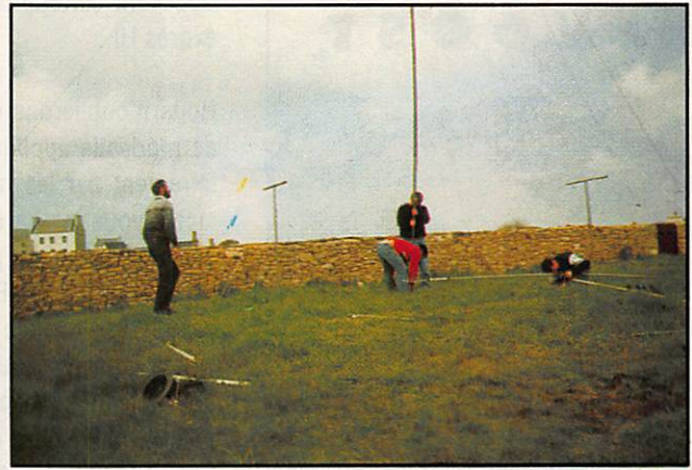
Installation des aériens. Les pile-up attendent.
