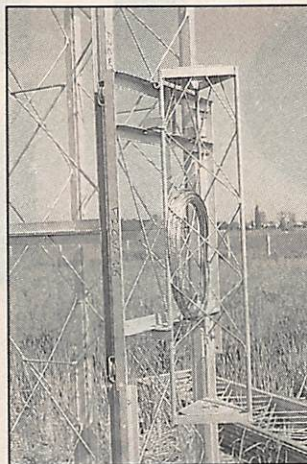
Mise en place du chariot.
