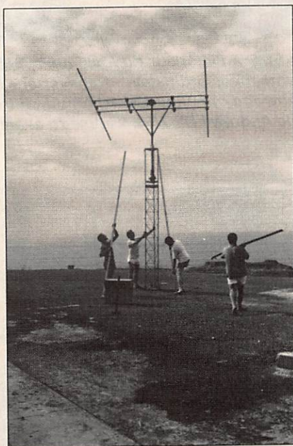
Montage de la structure support d'antennes.
