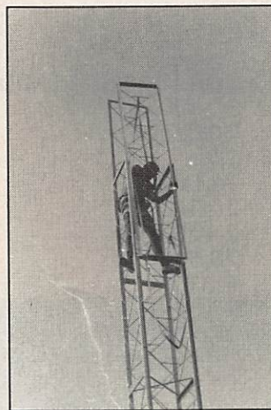
Montage d'un panneau.
