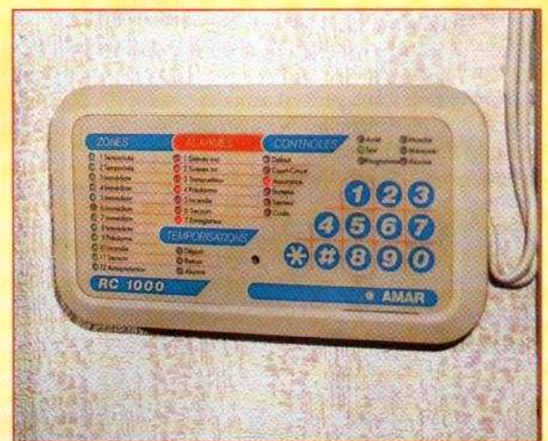
Un clavier déporté rend l'utilisation plus pratique si la centrale est cachée. L'accès y est possible par un code personnel. Notez les indications de programmations de zones, d'alarmes, de temporisations et de contrôles séparés, rendant la manipulation plus facile.
