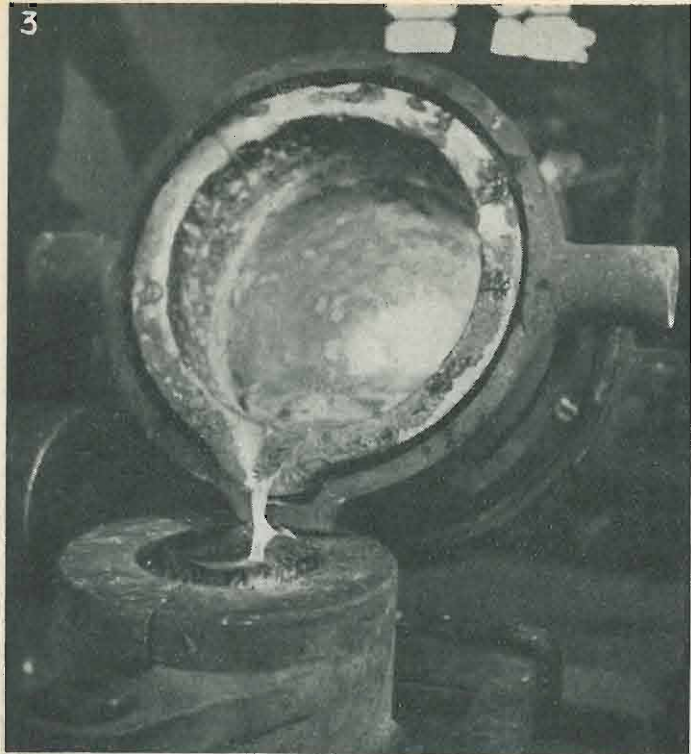
3. La colata di una billetta da trafilatura.
