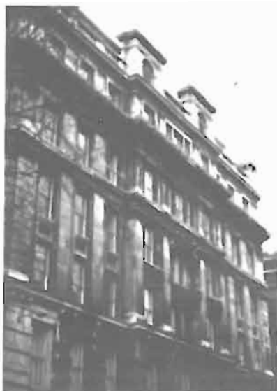
Fig. 2 - Nel primo abbaino ad arco del tetto del Palazzo delle Poste, che conserva tuttora la struttura vecchia di oltre 100 anni; Marconi installò il trasmettitore.
