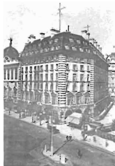
Fig. 7 - La Marconi House nel 1924. Sul tetto si vedono i due supporti dell'antenna multifilare del radiodiffusore: il primo della BBC; che irradiava in onde medie dal 1922 al 1925. Poiché i ricevitori per radiodiffusione del tempo erano prevalentemente «a galena» senza amplificazione; tanto questa stazione (2LO) quanto le altre, quasi contemporanee, venivano installate nel centro della città per assicurare una migliore ricezione.
