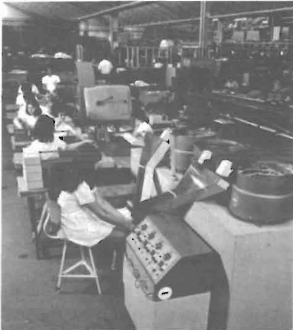
Fig. 10/2 - Impianto elettronico automatico per il conteggio di piccole parti.
