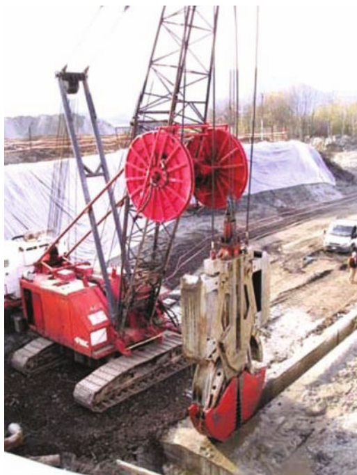
Fig. 18.38. Gru dotata di benna idraulica utilizzata per lo scavo della barriera
