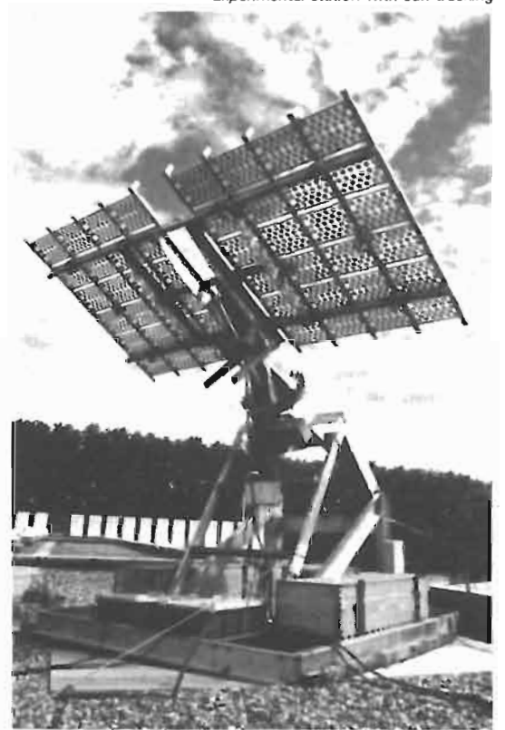
Station expérimentale avec suivi du soleil Experimental station with sun tracking
