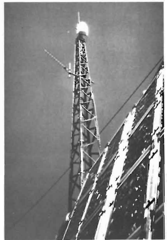
Réémetteur de Télévision T.V. transponder
