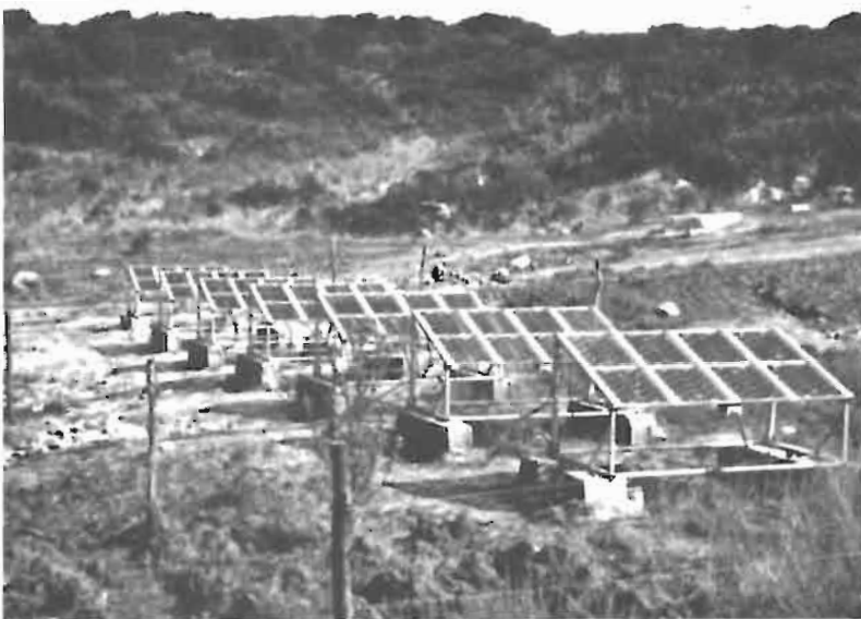
Pompage de l'eau Water pumping
