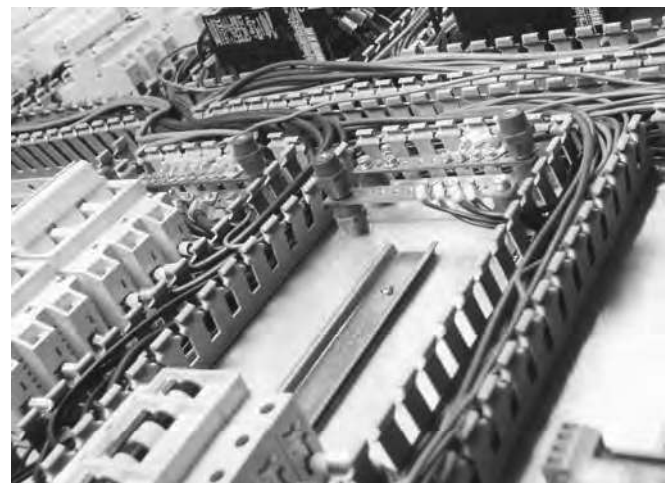
Fig. 6.339 - a) Colori per l'identificazione dei conduttori - b) Esempio di applicazione di canalette per cablaggio e accessori (Bocchiotti).
