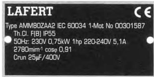
Fig. 7.53 - Esempio di targa per motori asincroni monofase (Lafert).
