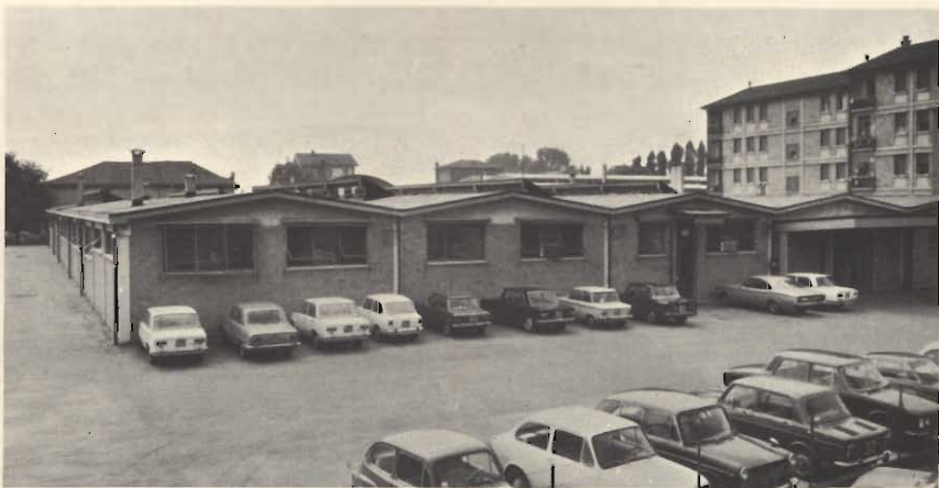
Veduta esterna dello stabilimento R.C.F. di Reggio Emilia.
