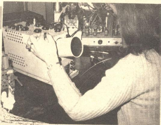
luminosa orizzontale, è assai probabile che l'oscillatore sia inerte, e per constatarlo si può collegare l'assieme cuffia-condensatore tra la griglia del triodo V1 e la massa. Se in questo punto si ode un rauco ronzio, certamente lo stadio funziona.
