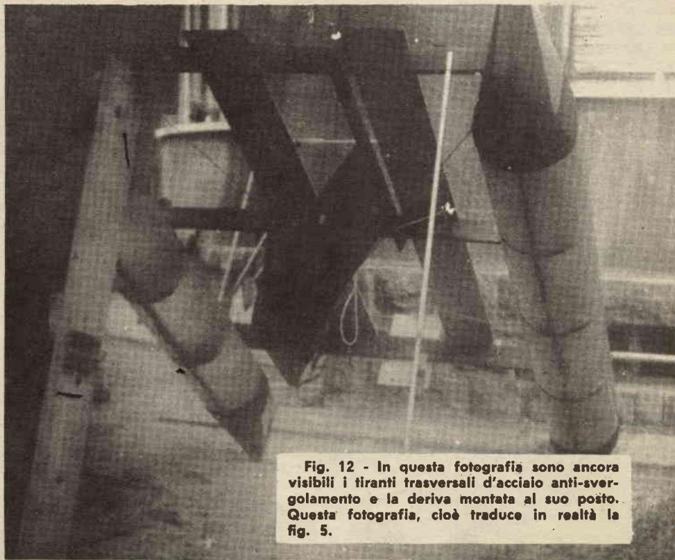
**Fig. 12 - In questa fotografia sono ancora visibili i tiranti trasversali d'acciaio anti-svergolamento e la deriva montata al suo posto. Questa fotografia, cioè traduce in realtà la fig. 5.**
