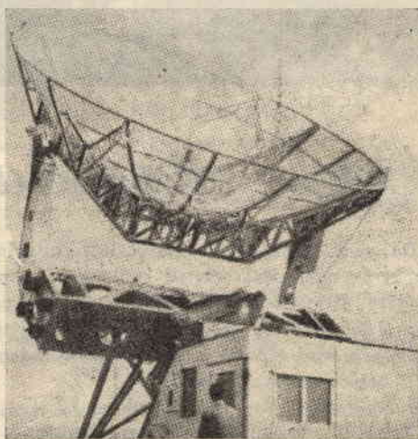
Fig. 3. — Anche gli scienziati tedeschi si interessano con solerzia allo studio delle radio-onde emesse dai corpi celesti. In figura potete notare un vecchio impianto radar adattato con particolari accorgimenti all'indagine della volta celeste.
