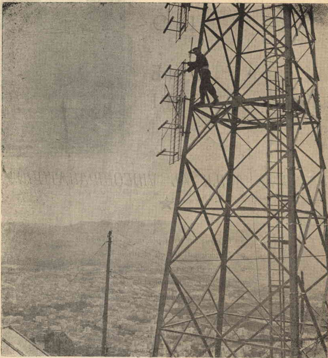
La nuova antenna del Centro trasmettitore di Monte Pellegrino Palermo
