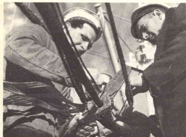
In fotografia si vedono due tecnici intenti ad impiombare la parte terminale del cavo che, attraverso 2.300 miglia di oceano, collega la Scozia con Terranova. L'impiombatura, che richiede diverse ore di lavoro, viene poi collaudata per mezzo dei raggi X.
