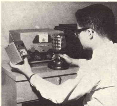
Il monitor meter, che può venir usato sia in casa sia all'aperto, non richiede alcuna connessione diretta con la linea di alimentazione dell'antenna.
