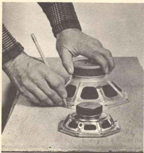
Fig. 2 - Si usino da guida gli altoparlanti per tracciare i tagli ottagonali sui pannelli.
