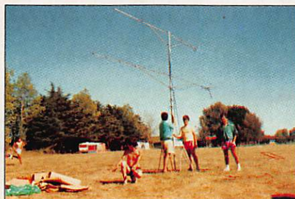
Installation des antennes VHF/UHF
