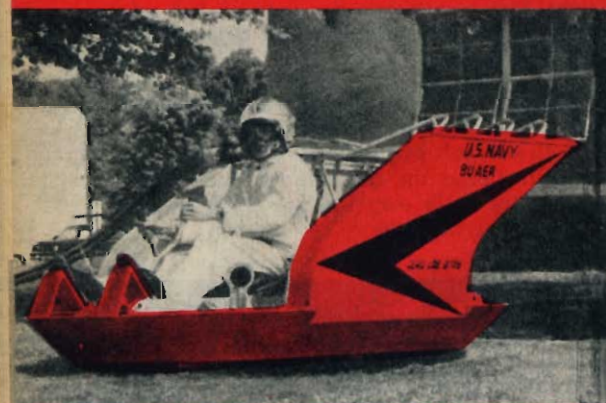
Sotto: La aerodina a sostentamento prefabbricato, del Dr. Alexandre Lippish. Con questa macchina, la portanza è generata direttamente dal motore.
