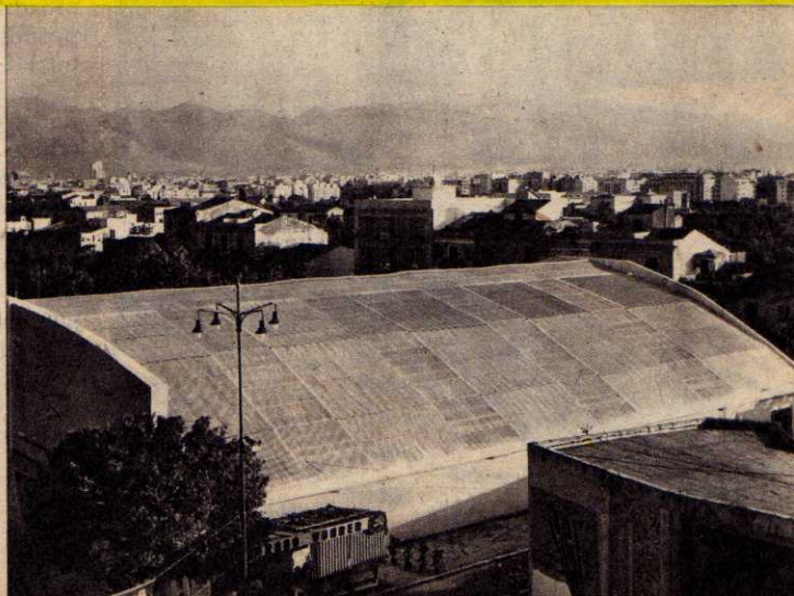
A sinistra: Una elegante e razionale pavimentazione in polivinilcloruro della Soc. Flexa di Milano. A destra: Copertura di un grande capannone realizzata con lastre ondulate di poliestere con rinforzo vetroso.
