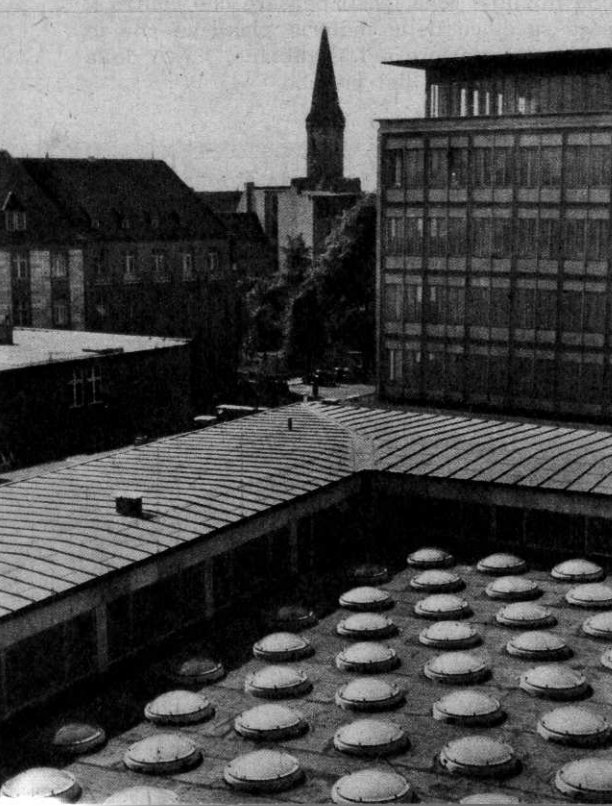
Sopra: Il grattacielo Galfa di Milano nella cui realizzazione hanno trovato vasto impiego le materie plastiche. Sotto: Una sezione della vetratura, composta di 150 cupole in Rohaglas, del tetto della Cassa di Risparmio di Osnabrück.
