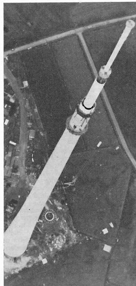
Fig. 4 - Vista aerea della torre di sostegno delle antenne del trasmettitore di TV di Emley Moor, Yorkshire, Inghilterra. La torre è alta 275 m; le antenne sono a quota 55 m sopra di essa e sono montate su di un pilone a traliccio in acciaio.
