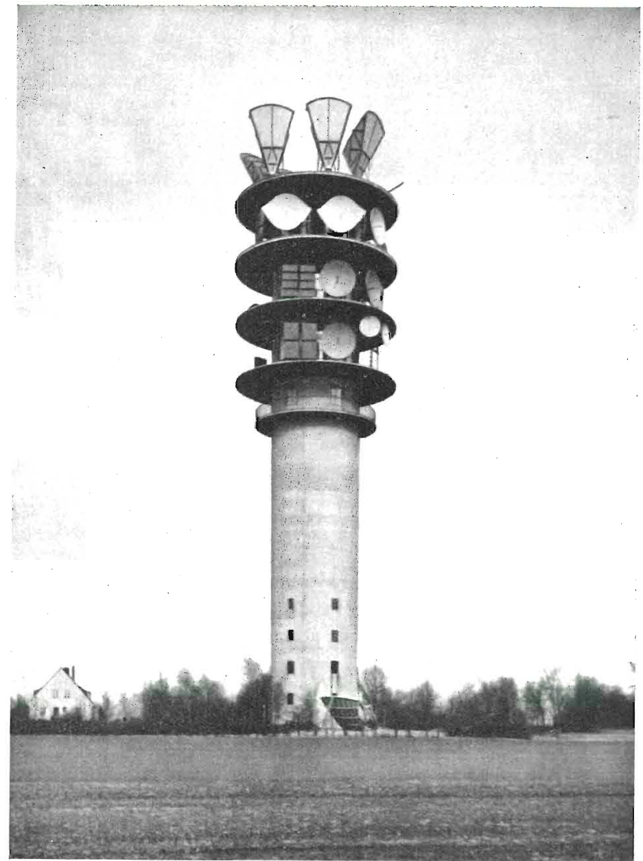
Esempio di torre costruita in Germania per il sostegno delle antenne destinate ad assicurare i collegamenti radio a grandi distanze. Sulla sommità gli specchi forniti dalla Telefunken per un ponte radio funzionante sui 2000 e i 4000 MHz.
