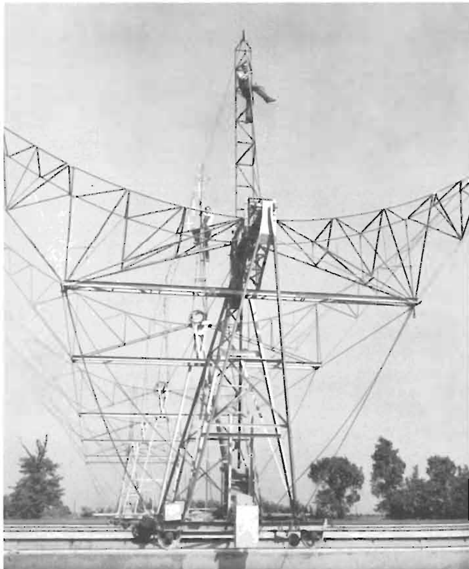
L'interferometro con la sua antenna scorrevole su rotaie ferroviarie è ripreso qui in fase di costruzione presso l'Osservatorio Mullard di Radio-Astronomia dell'Università di Cambridge in Inghilterra. La struttura di acciaio è terminata e parte del dipolo è messa in opera. La rotaia si estende per oltre 300 metri e la lunghezza dell'antenna è di 57,9 metri.
