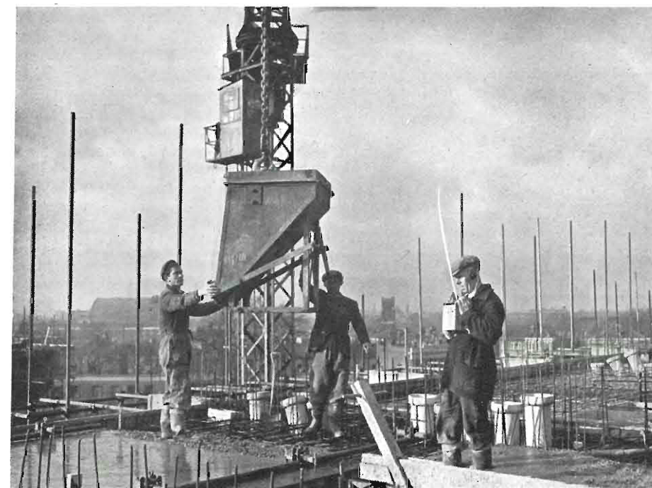
La radio nell'industria: un operaio addetto ad un cantiere edile, dà istruzioni all'operatore posto nella cabina di una gru a braccio, utilizzando un « walkiephone » di costruzione Pye.
