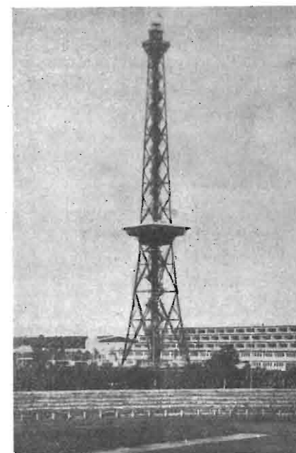
Berlino: Una delle torri di ammassaggio dell'antenna (138 m.)
