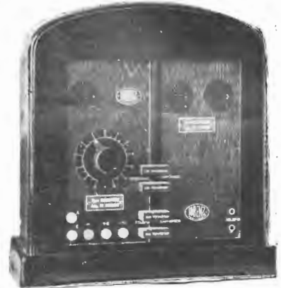
Apparecchio ricevente a 3 valvole approvato dall'Istit. Super. P.T.T. 250 - 700 m.
