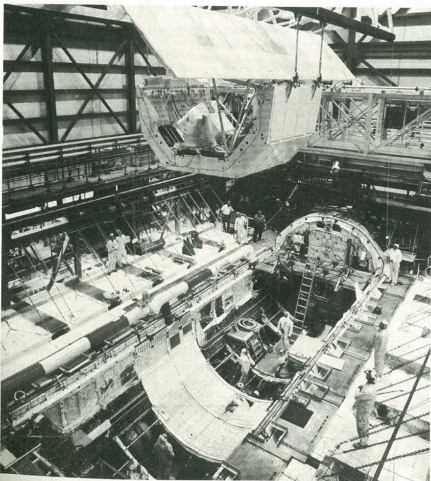
Figura 1. Inserimento del portastrumenti nella stiva dell'Orbiter (STS-2)
