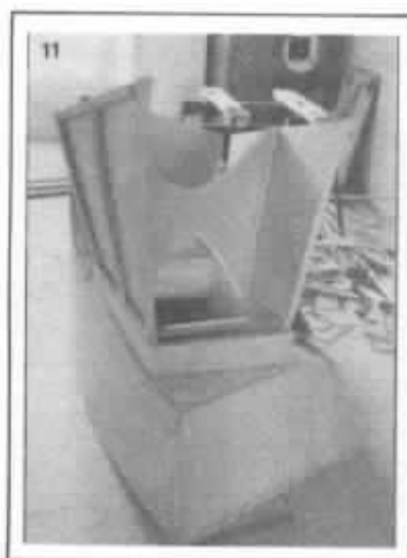
Construction du 1 er élément vertical. Le tasseau mince sur la cloison interne permet de bien évaluer la courbure. Le tasseau qu'on voit en haut, au 1 er plan, donne l'écartement exact entre les deux parois.
