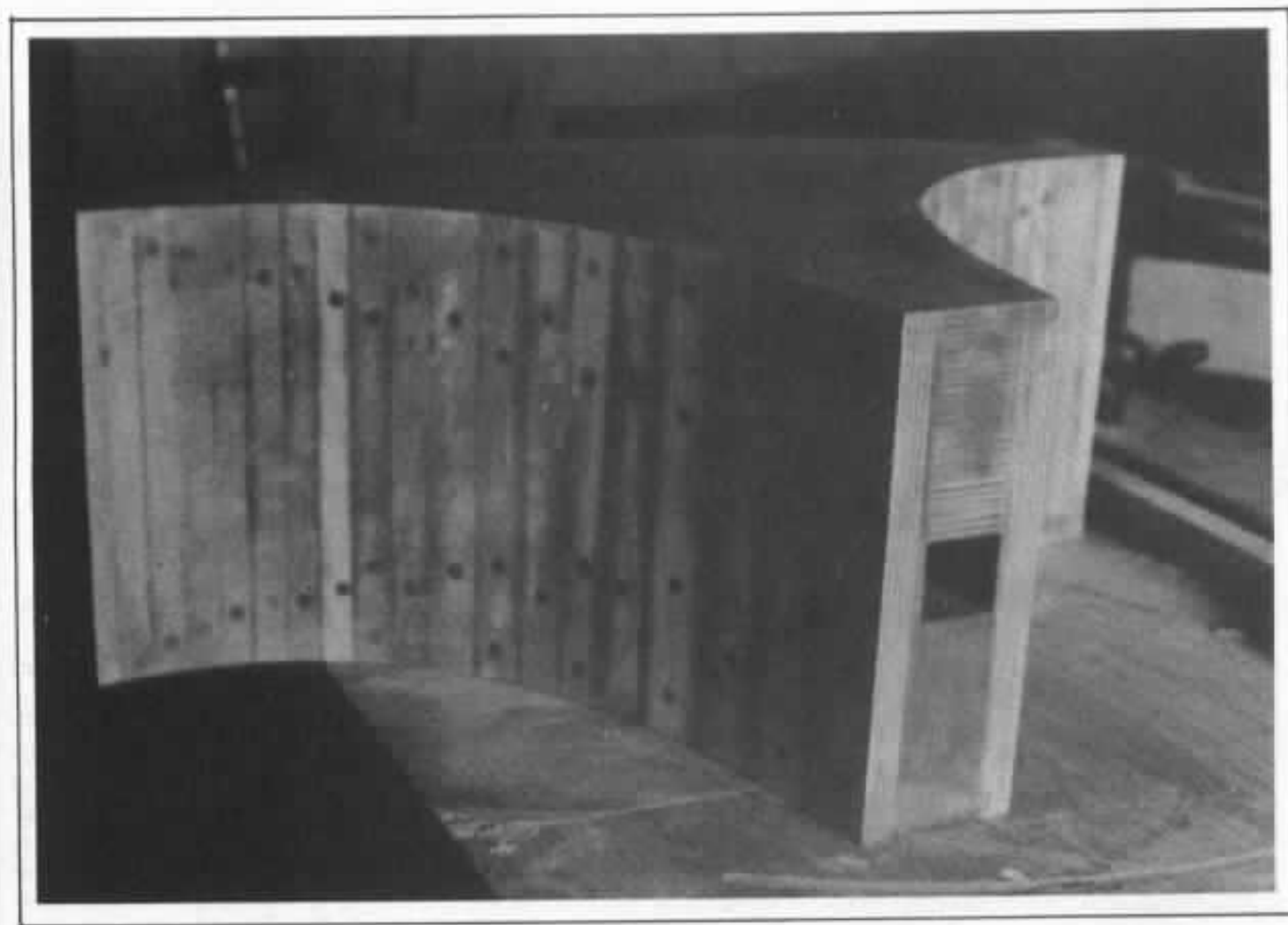
Photo 14 : On distingue les têtes de vis. C'est du solide ! Masticage et ponçage général. On termine le latté en collant une nouvelle bande de contreplaqué de 3 mm.
