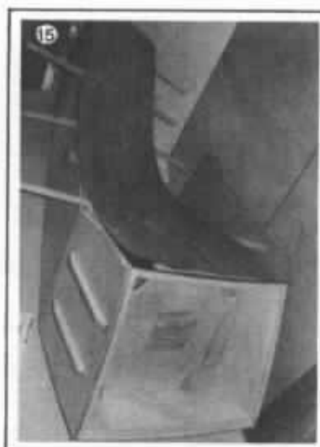
Placage d'une paroi entière du volume horizontal. Grâce à des rondelles insérées entre l'élément de base et l'enceinte close, la lame du cutter peut glisser entre les deux pour couper le bois de placage.
