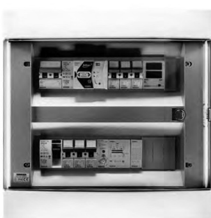
Fig. 7.7 - Esempio di centralino con dispositivo di controllo dei carichi (in alto a destra). Si noti il sovradimensionamento del 15% dei moduli necessari, con un minimo di due moduli di riserva.
