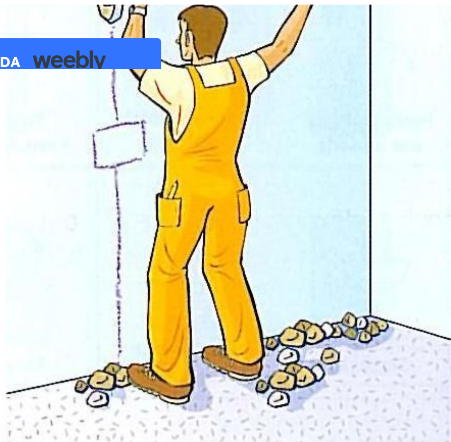
2. Scanalare la parete
