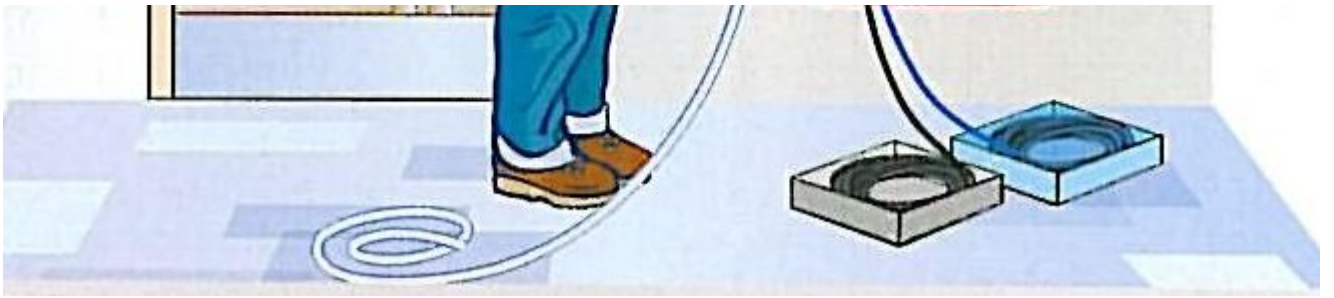
3. Operazione di infilaggio direttamente dalle matasse scatolate
