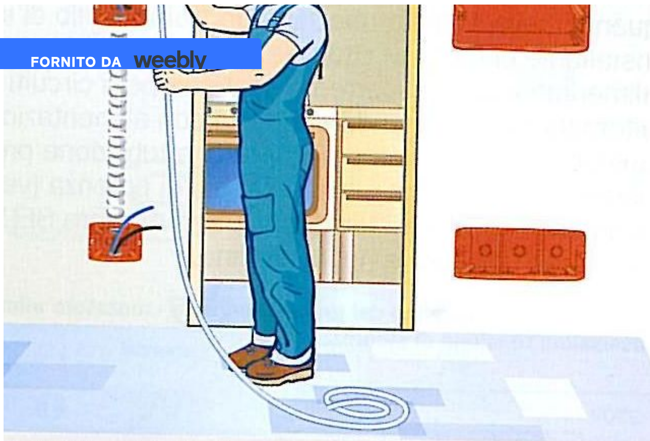
2. Infilaggio cavi dal locale caldaia al termostato
