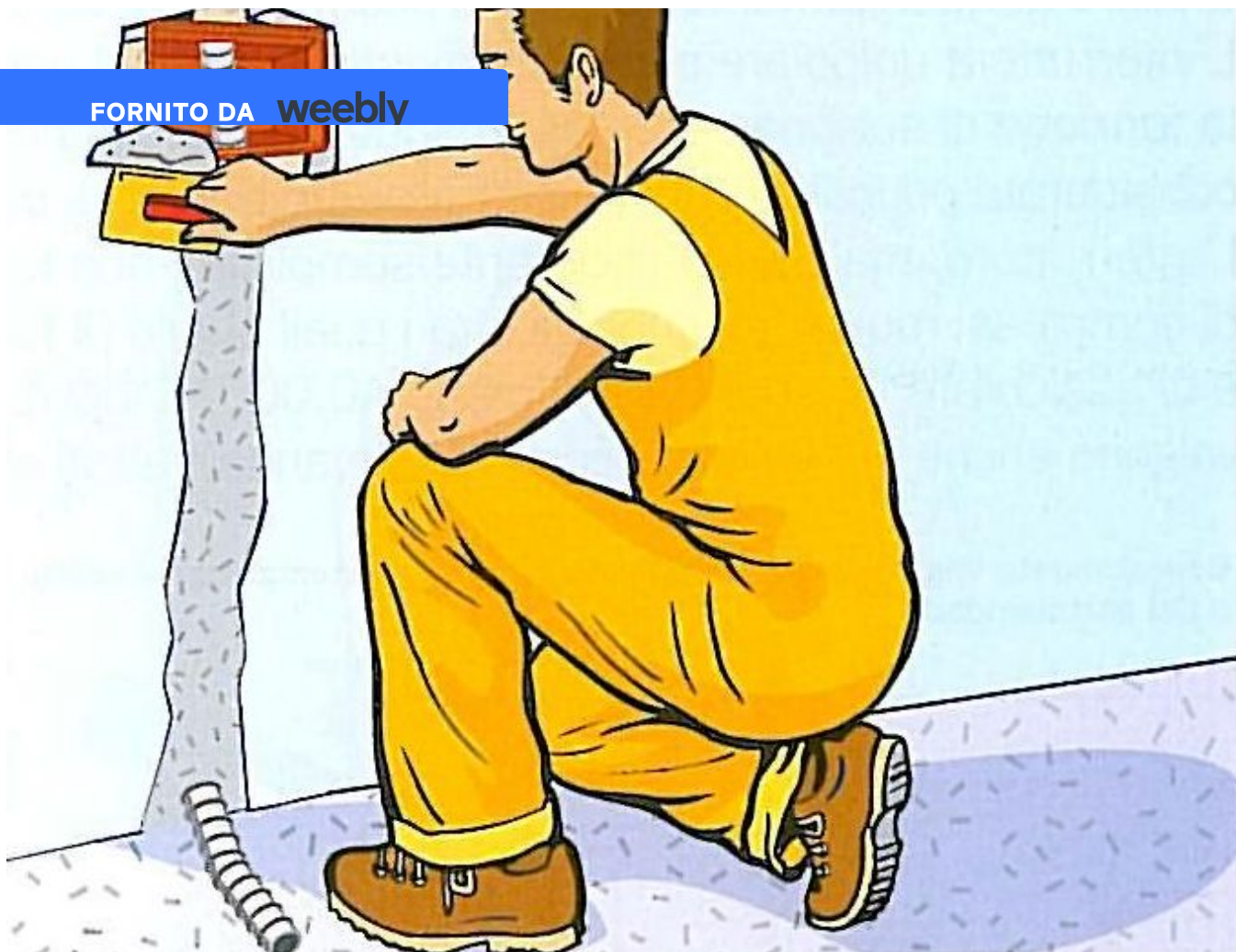
2. Chiusura della scanalatura con la malta
