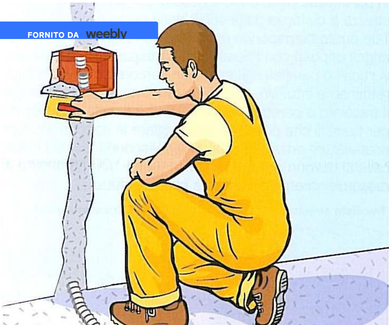
2. Chiusura della scanalatura con la malta
